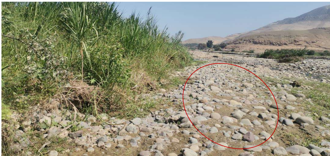
FIGURA N°05: , PROG. 3+200 - LA EXISTENCIA DE AREAS COLMATADAS POR ENCIMA DEL CAUCE Y EXISTENCIA DE DIQUES EROSIONADOS POR UNA AVENIDA.
