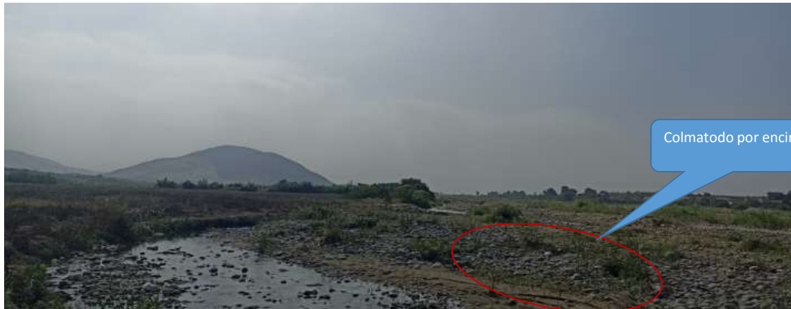
FIGURA N°04: , PROG. 3+150 - LA EXISTENCIA DE AREAS COLMATADAS POR ENCIMA DEL CAUCE HACE QUE REPRESENTA UN GRAVE RIESGO A UNA AVENIDA FLUVIAL SIENDO VULNERABLE AMBAS MARGENES DEL RÍO.
